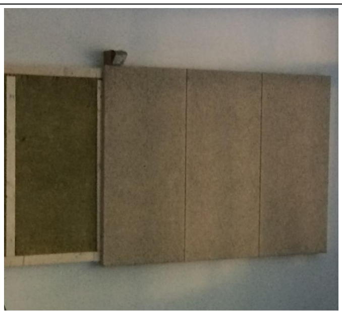
Holzwolepaneel auf Holz-UK mit Mineralwolle-Einlage, Montage
