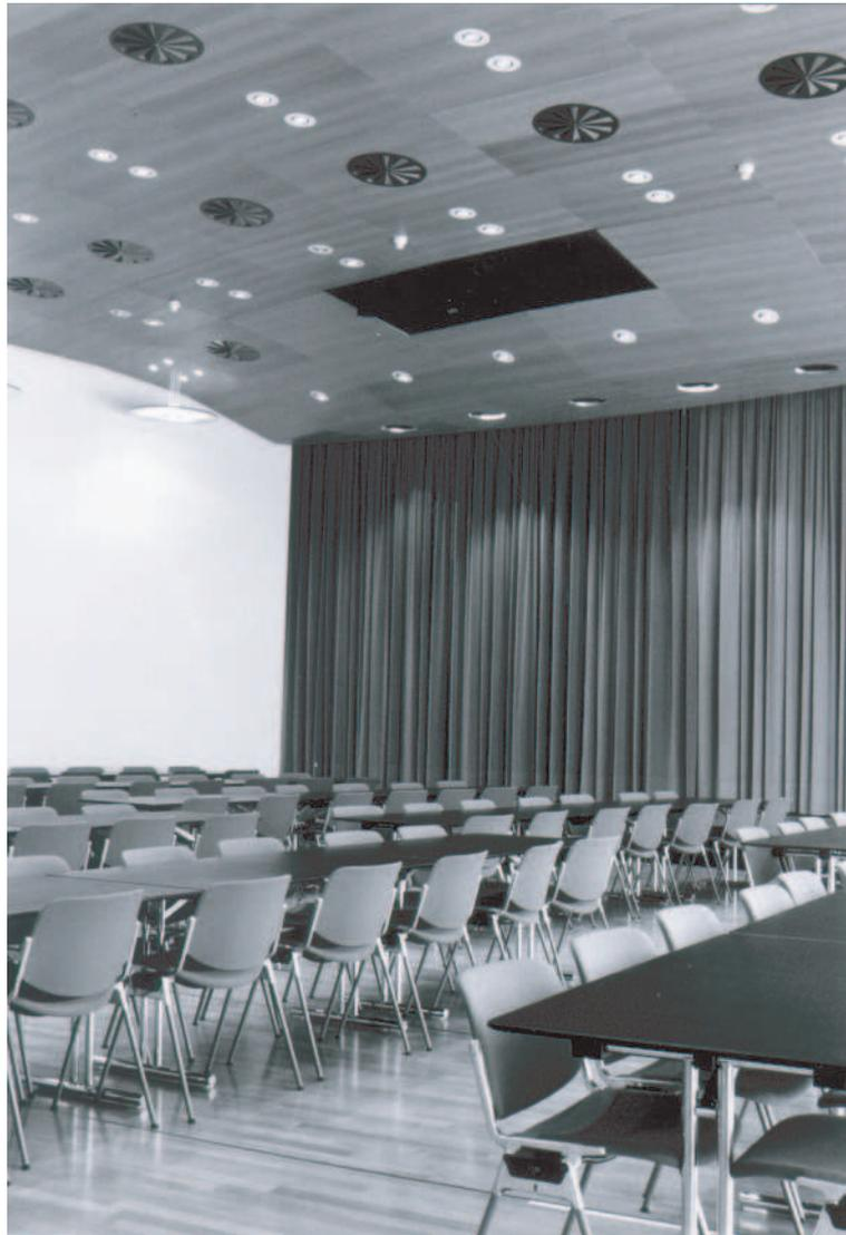
Abbildung 6.3: Unsichtbare Zentralbeschallung im Stadthausaal Illnau-Effretikon. Von der zentralen Position in der Decke ist einer der Lautsprecher ins Parkett, der andere auf den Balkon gerichtet. Zusammen mit dem Tieftonlautsprecher ist die Anlage auch für die Übertragung von Musik geeignet. Die Lautsprecher sind im dunklen Deckenfeld eingebaut. An der gleichen Stelle befinden sich ferngesteuerte Verfolgerscheinwerfer.
