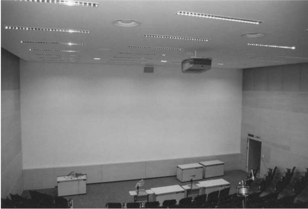
Abbildung 6.1: Zentralbeschallung in einem Hörsaal des Kantonsspitals St. Gallen. Der Lautsprecher befindet sich im Bild links vom grossen Videobeamer an der Decke.
