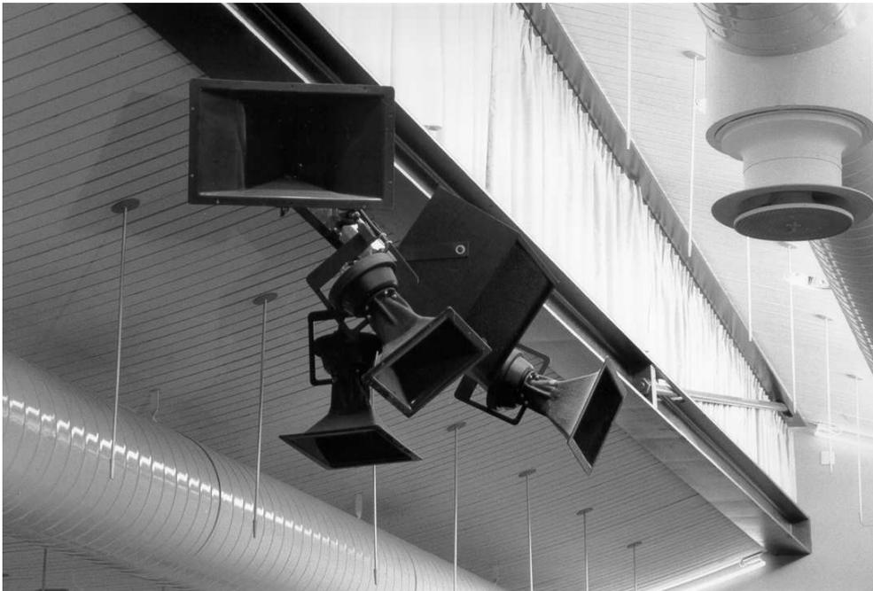
Abbildung 8.6: Typische Anordnung von Hornlautsprechern guter Qualität zusammen mit einem Tieftonlautsprecher im Mythenforum Schwyz. Die einzelnen Hornlautsprecher versorgen bestimmte Bereiche im Saal.
