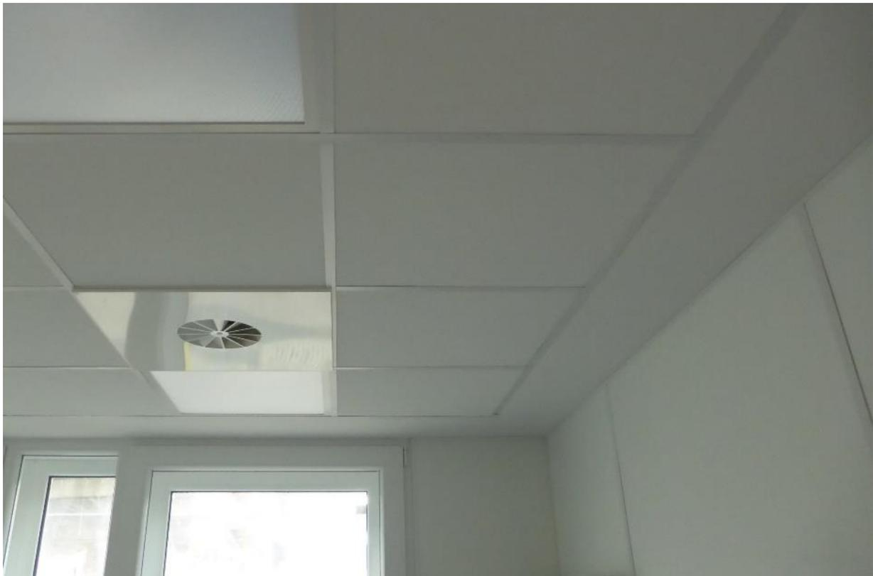
**Abbildung 8-5** Beispiel des Deckenanschlusses für ein schallabsorbierendes Wandpaneel an einen Gipskarton-Deckenfries
