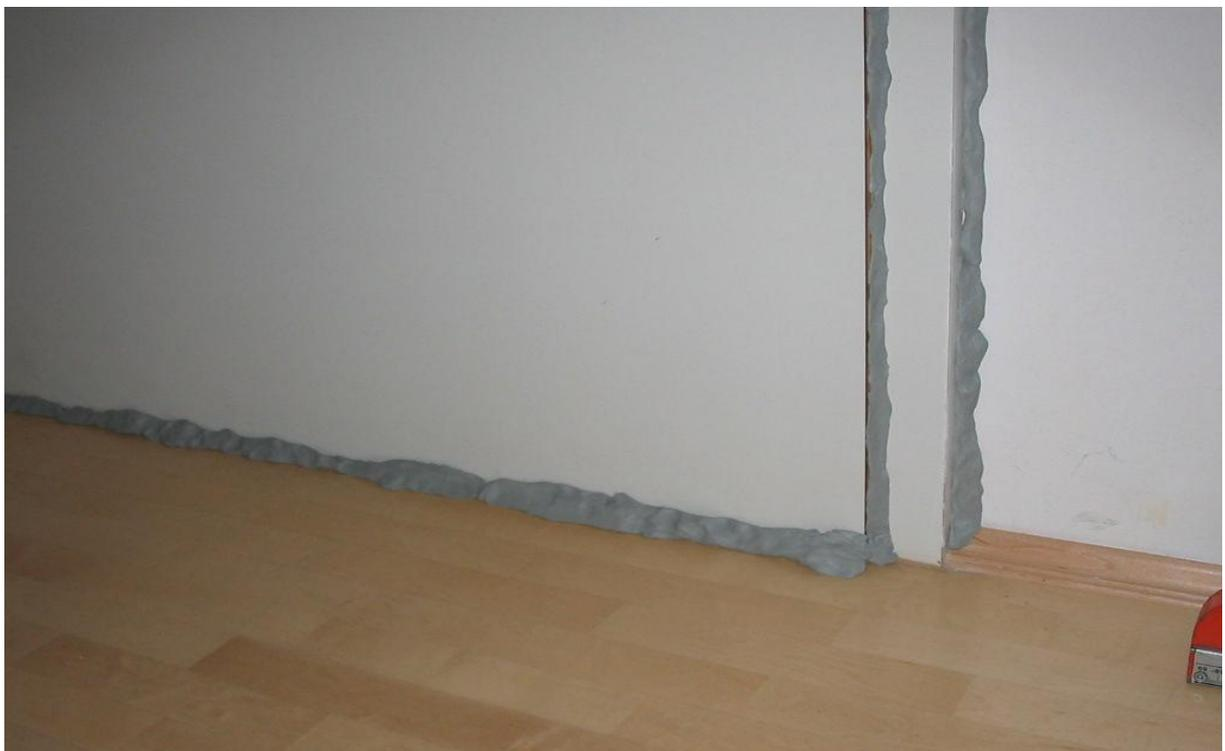
temporär abgedichtete Funktions- und Einbaufugen
