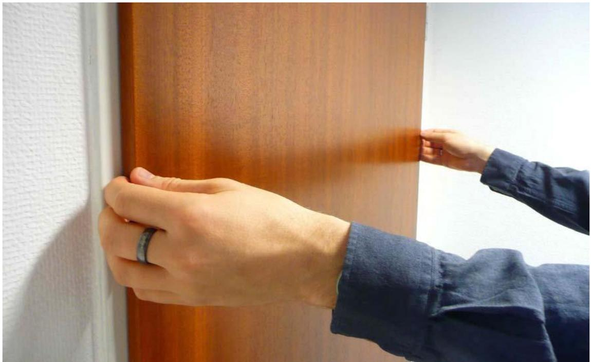
Überprüfung auf gleichmäßiges Anliegen
