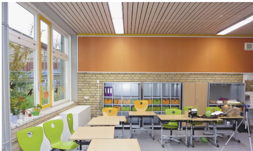
Bild 6: Klassenzimmer der Hauptschule in Nordrhein-Westfalen mit schallabsorbierenden Flächen in Form der Holz-Paneel-Decke und Rückwand.
