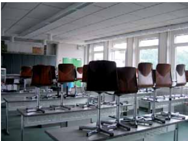
Abb. 23: Chemieraum II, V=200 \text{ m}^3 , Akustikdecke aus Mineralfaserplatten.
