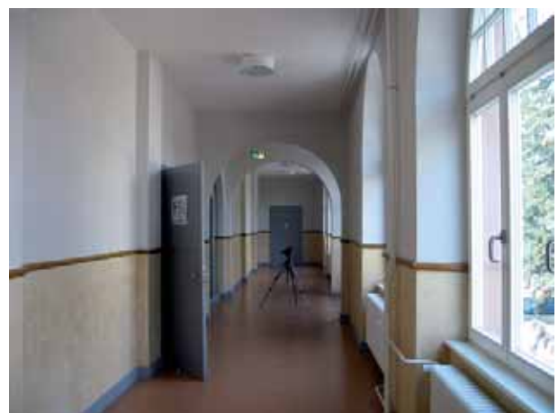
Abb. 28: Sanierter Flur der Gutenbergerschule ohne Akustikdecke.
