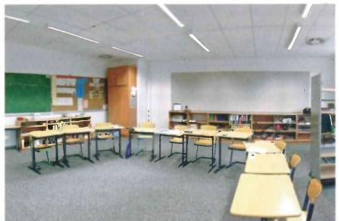
Abbildung 6: Beispielhafter Klassenraum der Elbschule, Hamburg: vollflächig hochgradig schallabsorbierende Decke, schallabsorbierendes Rückwandpaneel, Kugelgarn-Teppichboden.
