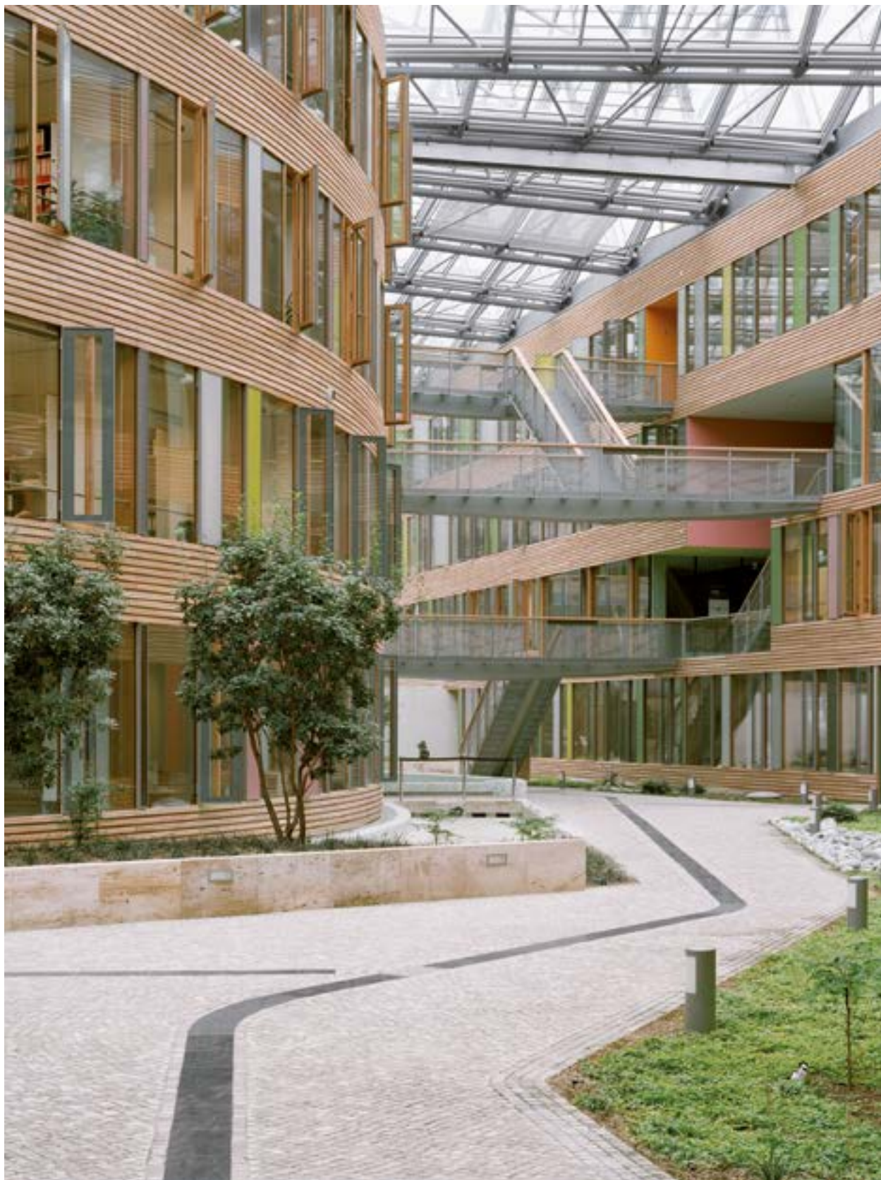
/ Bodenleitsystem – Umweltbundesamt Dessau (sauerbruch hutton architekten, ST raum a. Landschaftsarchitekten)
