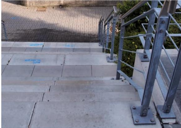
**Abbildung 42:** Positivbeispiel – Stufenmarkierung, Betonstufen im Außenbereich
