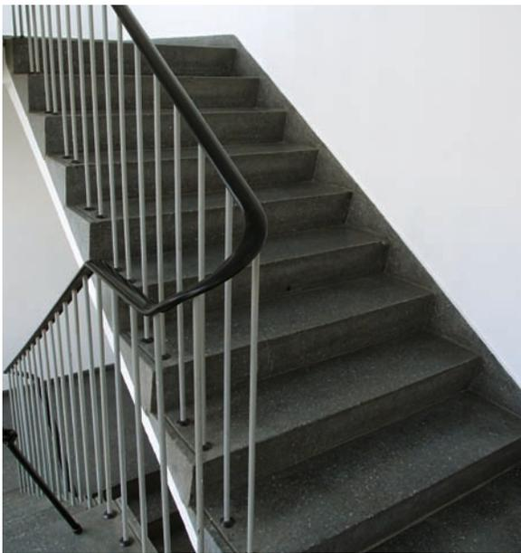
**Abbildung 40:** Positivbeispiel – Stufenmarkierung auf Linoleum
