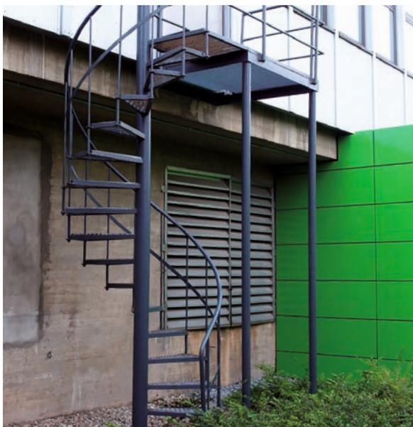
**Abbildung 44:** Negativbeispiel – Perspektive durch Gitterroststufen
