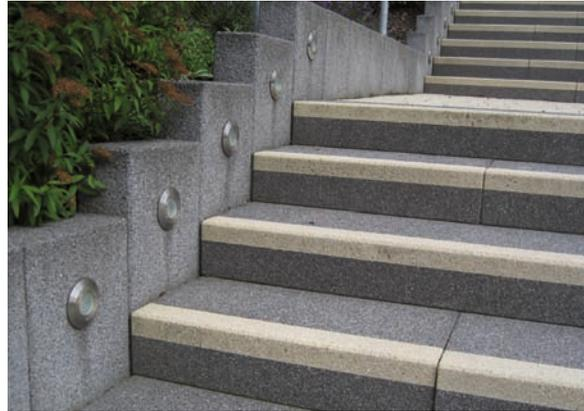
Positivbeispiele in stark frequentierten Außenbereichen bieten zum Beispiel Blockstufen, die kontrastierende Helligkeiten in einem Stein enthalten, wie Abbildung 42 zeigt. Alternativ können an Stufen auch Schienen aus Hartgummi, Metall, Holz oder Kunststoff eingesetzt werden. Auch Folien, Kaltplastiken und lackähnliche Materialien finden Verwendung, teils in reflektierender, retroreflektierender oder nachleuchtender Ausführung.
