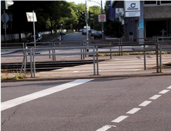
Abbildung 21 zeigt ein positives Beispiel einer ähnlichen Absperrung aus Metall im Wechselkontrast. Diese verhindert kontrastreich, dass Radfahrer unbedacht eine Straße kreuzen. Die Farbe des Wechselkontrasts spielt keine Rolle und könnte variiert werden, solange die Helligkeitsunterschiede beider Farben ausreichen.
