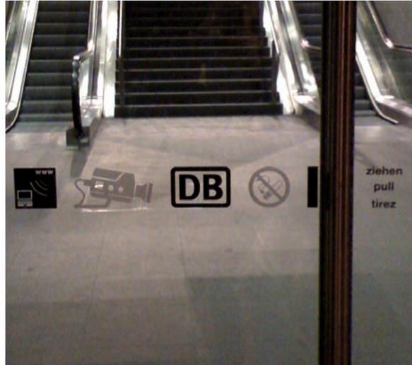
Bei der Etagennummerierung ist die Umgebungsfläche eine hell gestrichene Rauputzwand, bei den Markierungen auf Glas bildet der Hintergrund, in der vorliegenden Perspektive ein Bodenbelag, die Umgebungsfläche zur Kontrastermittlung.
