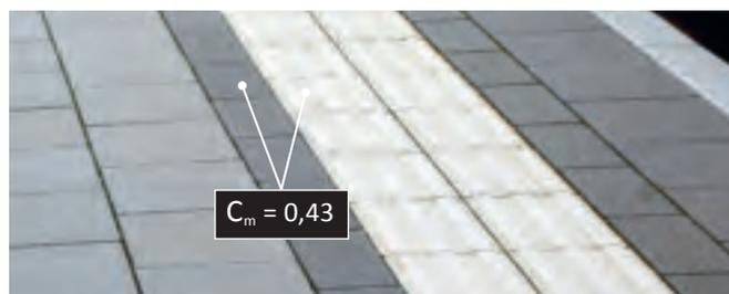
Die Sicherheitslinie weist bei trockener Oberfläche einen Kontrast von  $C_m = 0,43$  zum anthrazitfarbigen Begleitstreifen auf.
