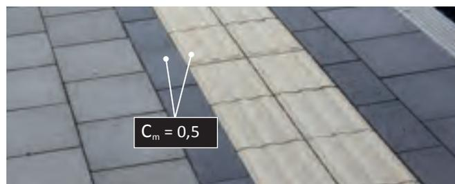
Bei Regen verändert sich die Helligkeit der Betonsteine unterschiedlich stark. Bei diesem Beispiel erhöht sich dadurch der Kontrast auf  $C_m = 0,5$ .
