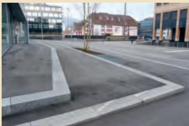
Kontrastreiche Kennzeichnung einzelner Stufen auf einer platzartigen Treppenanlage.
