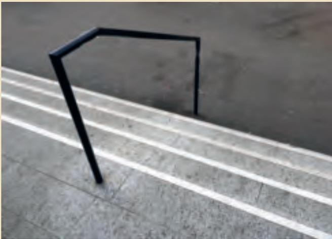
Bei kurzen Treppen wird jede Stufenvorderkante mit einer Markierung gekennzeichnet.
