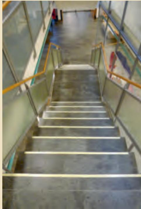
Werden alle Vorderkanten markiert, ist die Treppe anhand des repetitiven Musters erkennbar. Zwischenpodeste und das Ende des Treppenlaufs sind ablesbar.
