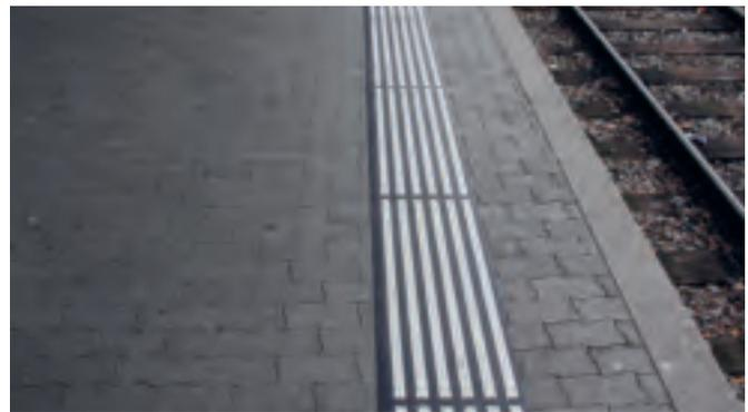
Die taktil-visuelle Sicherheitslinie aus Kaltplastik wirkt zusätzlich zum Helligkeitskontrast durch den Materialwechsel, das geometrische Muster und dessen Strukturhöhe.
