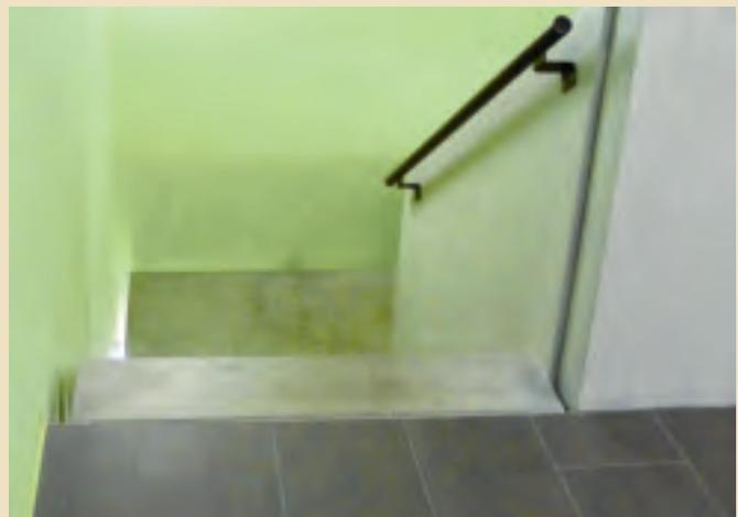
Im geschlossenen Treppenhaus kann anstelle einer Stufenmarkierung der Treppenlauf mit dem erforderlichen Helligkeitskontrast gegenüber dem Bodenbelag hervorgehoben werden.
